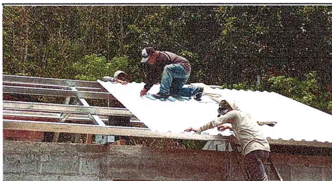
Foto 3: Colocando laminas troqueladas
