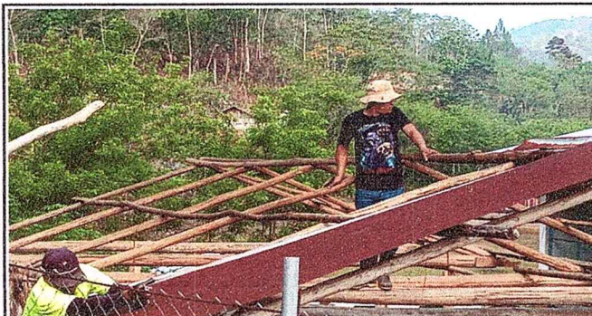
Foto1: Desarmando el techo para mejorar por costaneras
