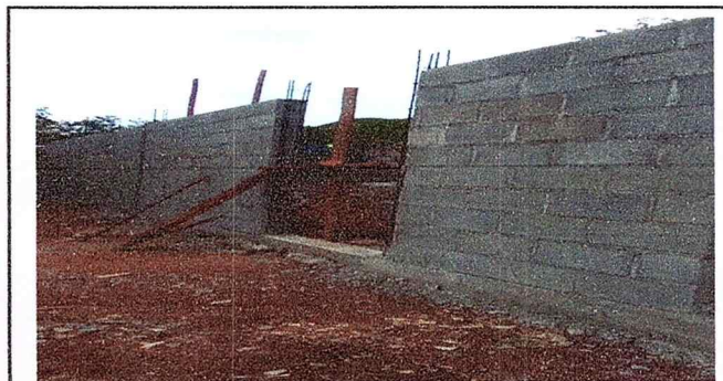
Foto 5: Reparacion en paredes
