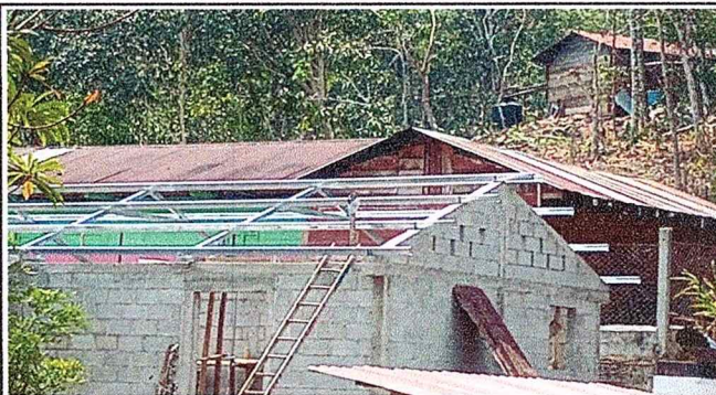
Foto 2: Instalando costaneras galvanizadas
