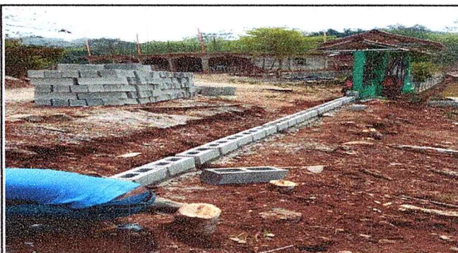
Foto 4: Proceso de construccion del muro perimetral
